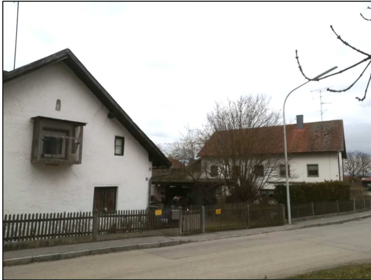
Blick von der Thalkirchener Straße auf das Wohnhaus (links) und den eingefriedeten Hofraum
